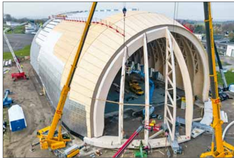
In Aachen wurde auch der Neubau des Luftschiffhangars am Flughafen Mühlheim vorgestellt, eine anspruchsvolle Holzfachwerk-Konstruktion mit innovativen, metallfreien Holzverbindungen. Fotos: Virtua ethic
