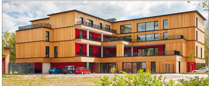
Dieses viergeschossige Mehrgenerationenhaus in Bad Oeynhausen wurde in Brettspertholzbaueweise erstellt, deren Elemente von Derix produziert wurden. Das Bauwerk ist einer der Preisträger des „Holzbaupreises NRW 2022“, der im Rahmen des Kongresses verliehen wurde. Foto: Derix-Gruppe
