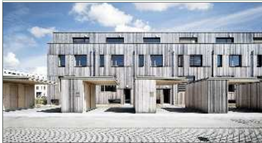
Das dreigeschossige Quartier Nonnewisen in Esch-Sur-Alzette (Luxemburg) zeichnet sich neben dem Passivhausstandard in Holzbauweise durch ein Nachhaltigkeitskonzept aus, das den Anschluss an ein Fernwärmenetz sowie ein Belüftungssystem mit Wärmerückgewinnung umfasst. Fotos: Ochs GmbH
