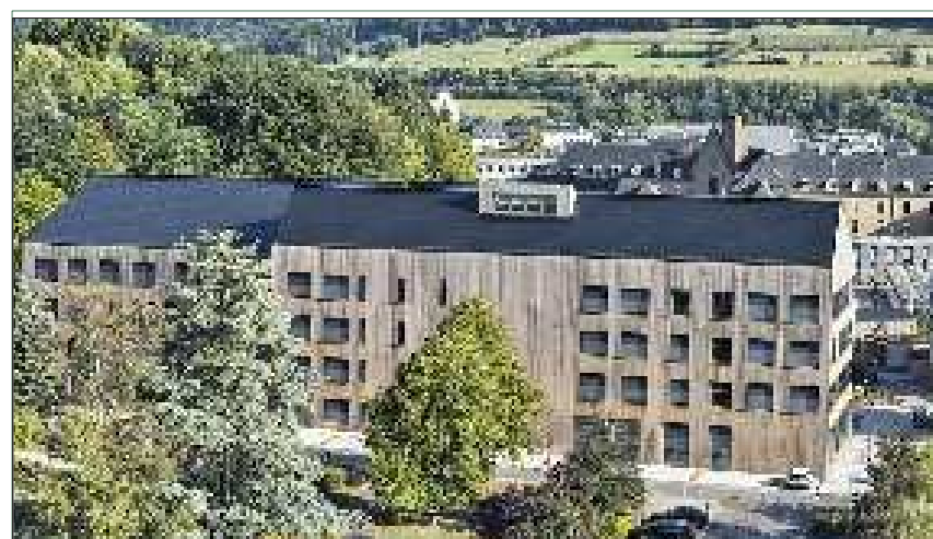
Diese neu erbaute, viergeschossige Schule für Krankenpfleger in Ettelbruck (Luxemburg) wurde neben der Konstruktion in Holzskellettbauweise für die erfolgreiche Umsetzung der Themen Nachhaltigkeit, Ökologie und Energieeffizienz ausgezeichnet. Foto: Christian-Aschman
