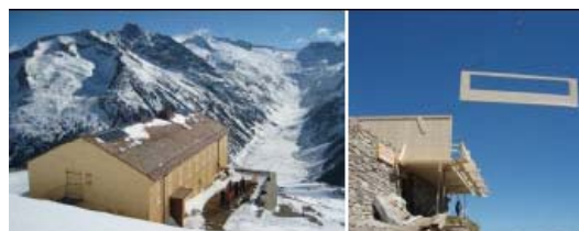
Neubau Olperer Hütte
