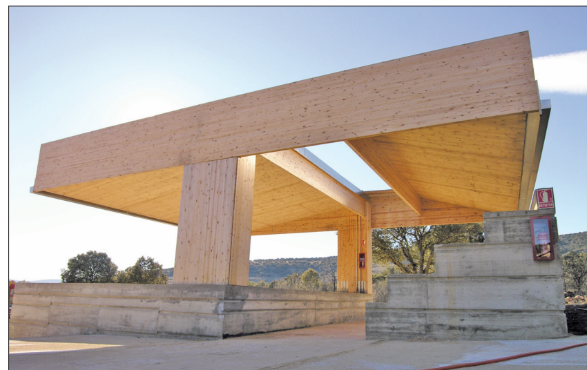
Miguel Nevado, Statiker und Planer aus Aldealegua bei Salamanca, stellte in Garmisch vor allem Bauten mit ungewöhnlichen Geometrien vor, die allesamt mit Brettsperrholz (CLT) gelöst wurden. Foto: Miguel Nevado
