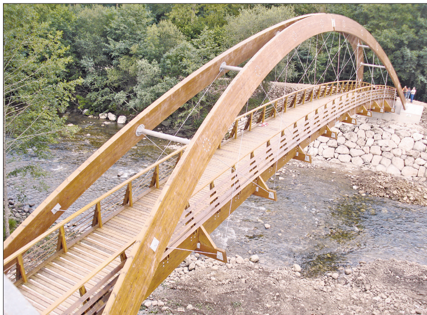
50 m lange Fußgänger-Bogenbrücke aus Brettchichtholz geplant vom Ingenieurbüro Media Madera aus Carreño (Provinz Asturien) Foto: Media Madera
