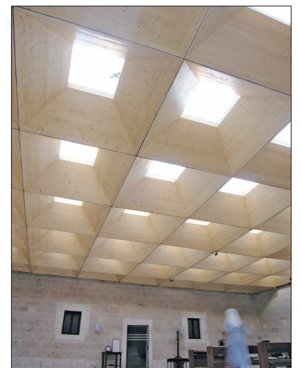
Dachkonstruktion einer Kirche bei Burgos: stützenfrei und relativ kostengünstig mit CLT ausgeführt. Foto: Nevado
