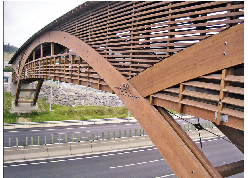
Diese überdachte Fußgängerbrücke überquert mit 60 m Länge die Autobahn A8, die an der Nordküste Spaniens entlang führt. Foto: Media Madera
