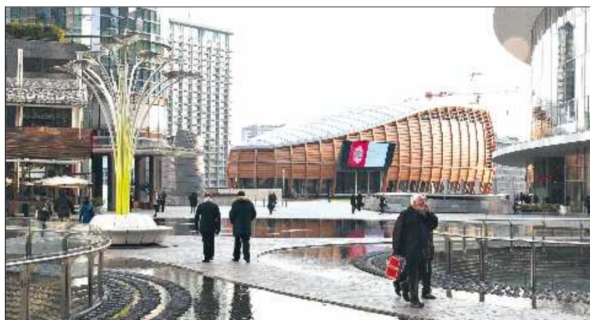
Der Maschinenstellerverband Acimall organisierte die Pressekonferenz im „Greenhouse“ der Bank Unicredit nördlich der Mailänder Innenstadt, das mit einer drei Stockwerke hohen, tragenden Fassade aus Brettchichtholz eher fremd wirkt innerhalb seiner Glas-Stahlbeton-Umgebung
