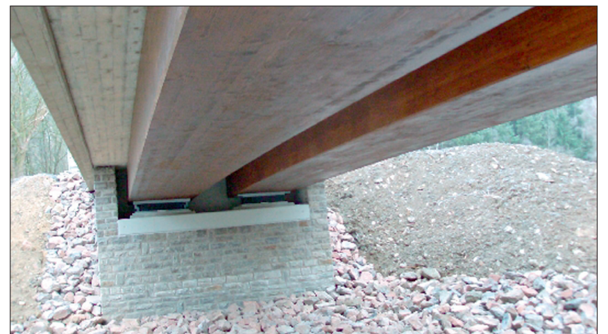
Brücke von unten: Blockverleimte Brettschichtholzträger, nachgiebig verbunden mit der Stahlbeton-Fahrbahnplatte.
