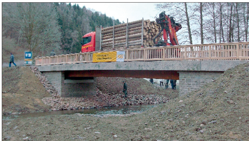
Eine Forschungsarbeit der Bauhaus-Universität Weimar in die Praxis umgesetzt: HBV-Brücke über die Wipper.
