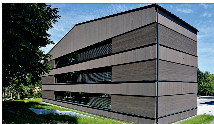
Strukturierte Fassade mit optimaler Montagerichtung der Lamellen; über den horizontalen Trennblechen ist die Holzverkleidung ebenfalls horizontal montiert.
