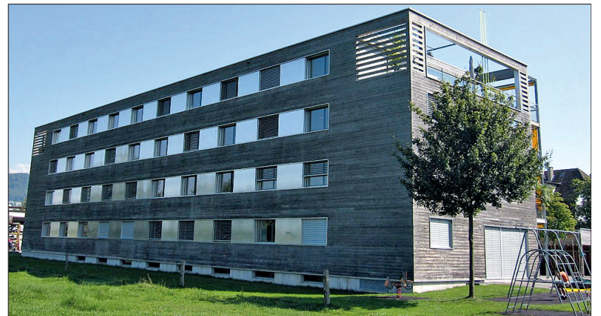
Das Holzbauprojekt Lorenzstraße im Schweizerischen Zug zeigt die Nachdunklung des Holzes unter einem UV-durchlässigen Anstrichsystem innerhalb von 15 Jahren (linkes Bild 2003 aufgenommen, rechts 2018).
