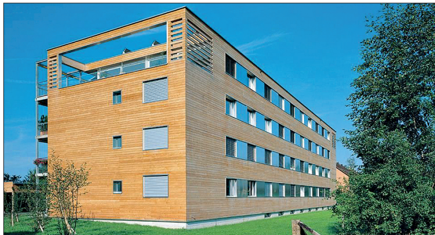
Das Holzbauprojekt Lorenzstraße im Schweizerischen Zug zeigt die Nachdunklung des Holzes unter einem UV-durchlässigen Anstrichsystem innerhalb von 15 Jahren (linkes Bild 2003 aufgenommen, rechts 2018).
