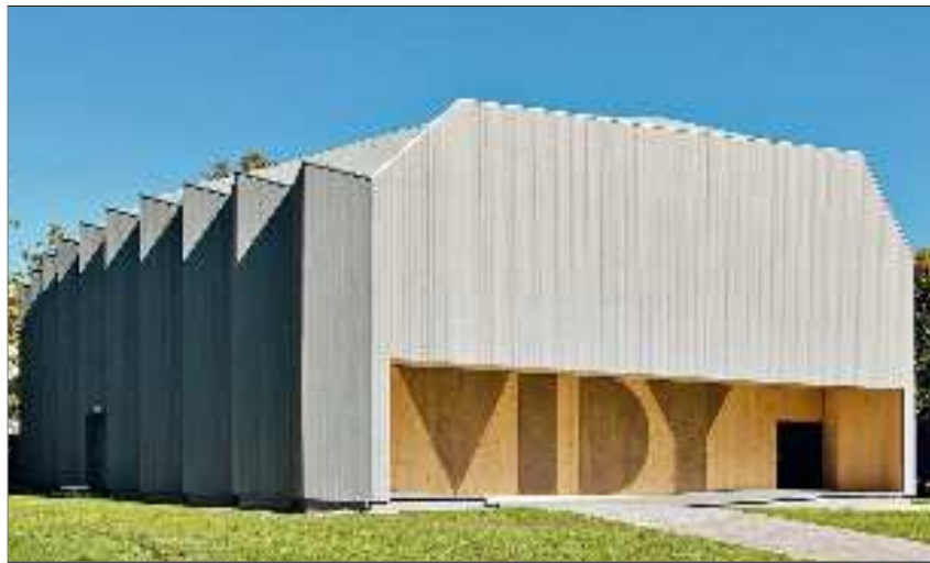
Gelungenes Holzbau-Experiment: Der 2017 fertig gestellte Pavillon des Théâtre de Vidy in Lausanne
