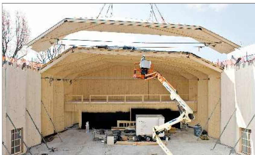
Etwa 20 m überspannen die 11 rahmenartigen Dachsegmente, die im Werk vorgefertigt wurden.
