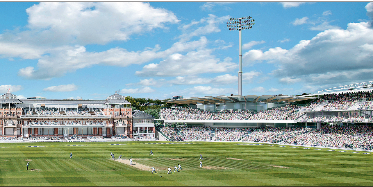
Die neue Tribüne des Lord's Cricket Ground-Stadions fällt durch ihre fächerförmig auskragenden BSH-Träger aus Amerikanischer Weißeiche ins Auge (derzeit im Bau). Rendering: Populous
