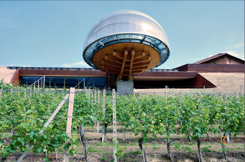
Weingut in Italien mit einer kuppelförmigen Aussichtsplattform, deren Brettschichthölzer aus Eiche an die Barriquefässer erinnern sollen. Foto: Simonin
