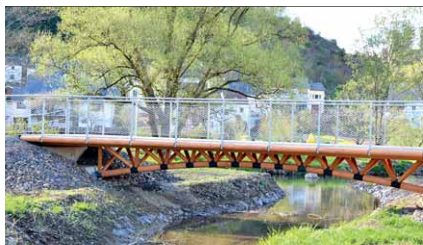
Preis auch für die Brücke Schönecken: Douglasien-Rundhölzer mit Polymerbeton-Verbindungselementen
