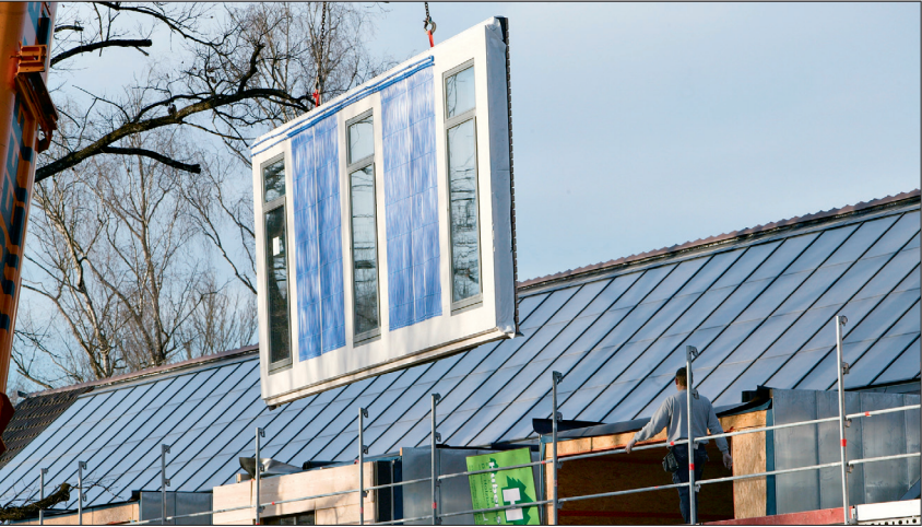
Die Firma Huber & Sohn in Bachmehring kombiniert bis zu 3 m breite Fassadenelemente aus Holz mit sogenannten Kapillarrohrmatten. Deren Röhrchen, die mit dem Heizungsrücklauf erwärmt werden, befinden sich zwischen neuer Dämmung und saniertem Mauerwerk. Dadurch wird erreicht, dass die raumseitige Oberflächentemperatur – unabhängig von der Außenlufttemperatur und den damit verbundenen Wärmeverlusten – konstant bleibt. Foto: Huber & Sohn
