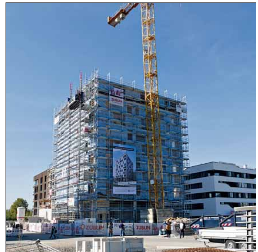
Das „Skaio“ auf dem Buga-Gelände in Heilbronn soll im März 2019 bezugsfertig sein und dann schlüsselfertig an den Investor übergeben werden. Fotos: Pirson
