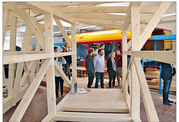
Das Team des Bauprojekts B realisierte ein auffälliges Dachwerk mit wechselnden Traufpunkten, bei dem sich die Lage eines jeden Sparren von den anderen unterscheidet. Im Hintergrund ist das Bearbeitungszentrum der hochschuleigenen Abbundanlage zu erkennen.
