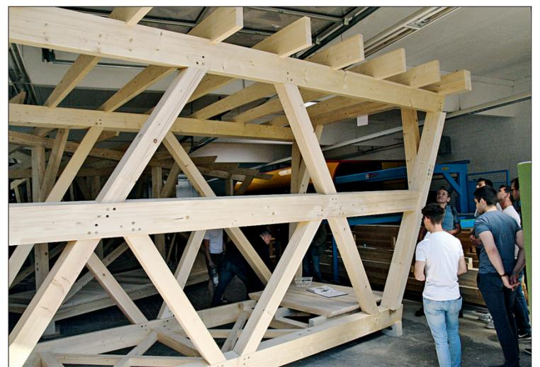
herkömmliche Zimmermannsverbindungen weist das Bauprojekt des Studententeams C auf, welches überwiegend auf Schwalbenschwänze oder Schlitz-Zapfen-Verbindungen setzte.
