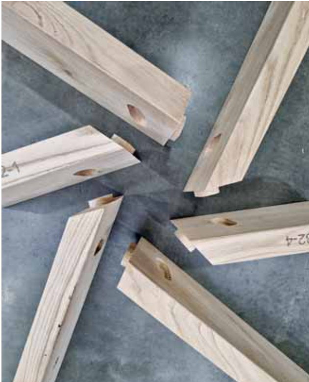
Auch die Friedberger Konstruktion ist eine selbsttragende Gitterschale, die ohne Verklebungen auskommt und gleichzeitig eine große Material- und Gewichtsparsnis ermöglicht. Fotos: TH Augsburg (3)
