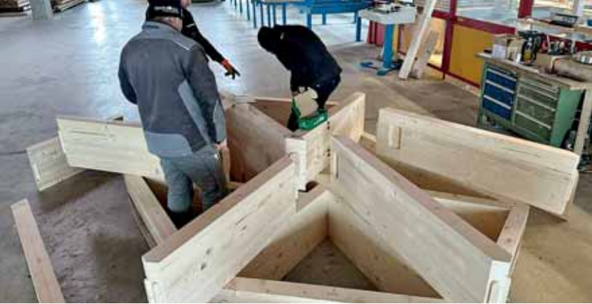
Vormontage eines Polygonalmoduls für das Tragwerk in Furth bei Holzbau Penzkofer in Eschlkam Foto: P. Hickl
