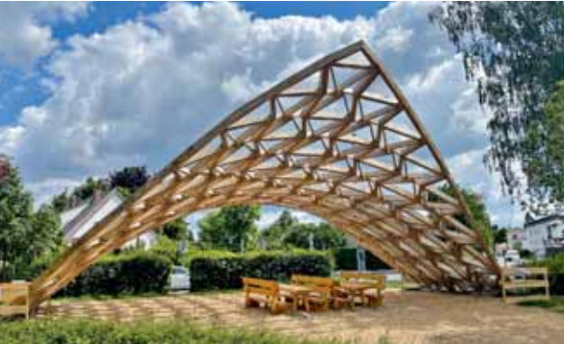
Das Projekt „Castanea Sativa Hypar“ im hessischen Friedberg ist ein in weiterer Prototyp eines leichten Flächentragwerks aus Kastanienholz.
