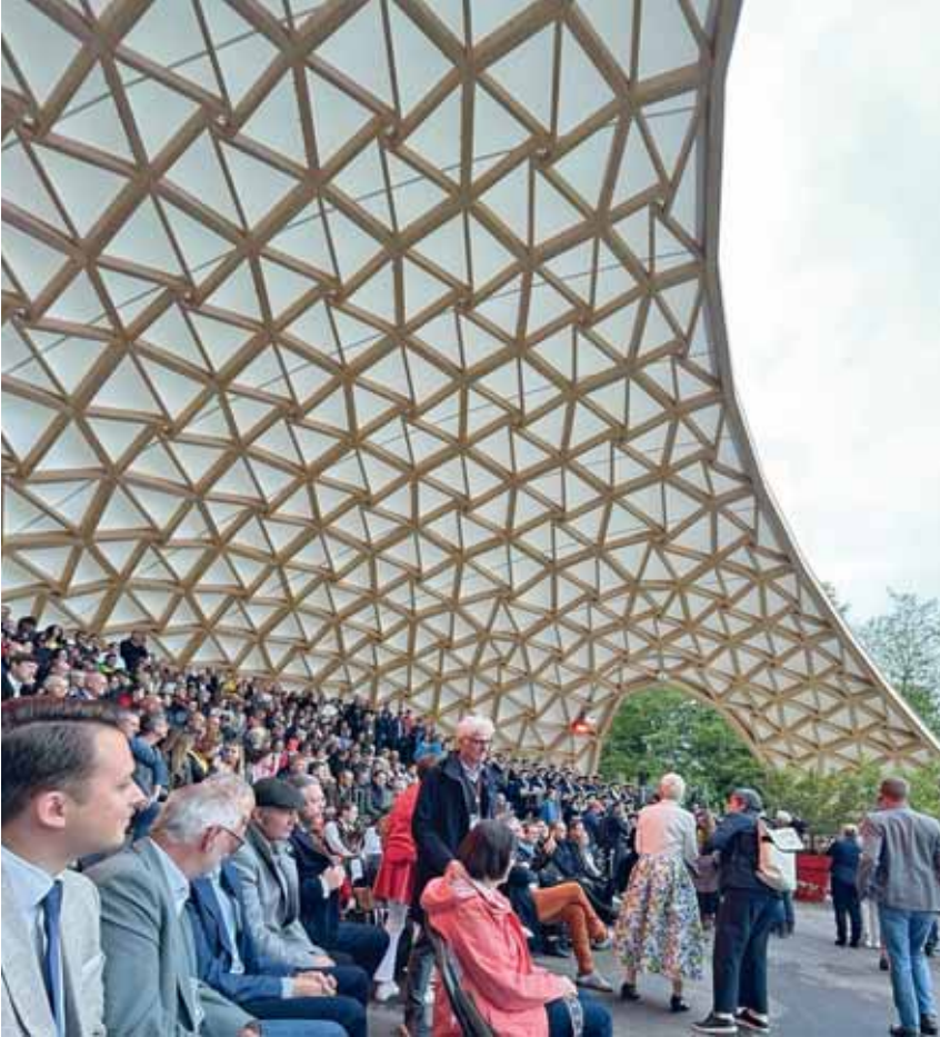
Hohe Materialeffizienz: Das Tragwerk der Parkarena Furth ist der vierte und bisher größte Forschungsdemonstrator eines neuartigen leichten Flächentragwerks aus kurzen, linearen Holzstäben. Fotos: TH Augsburg (3)
