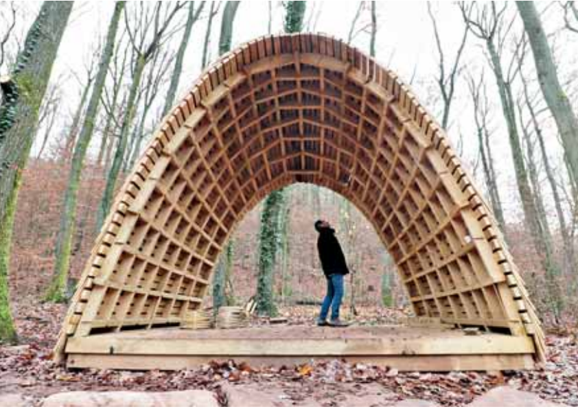
Der erster Prototyp aus Laubholz (Kastanie) bei Annweiler besteht aus einem montage- und fertigungsoptimierten, selbsttragenden (reziproken) Stabwerk, das die Möglichkeiten moderner Holz-Abundanlagen ausnutzt.
