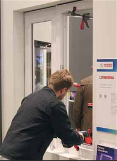
Finstral aus Südtirol demonstrierte auf dem IFT-Gemeinschaftsstand den Austausch alter Fenster im Einschubverfahren. Dabei verbleibt der alte Blendrahmen im Mauerwerk und dient als Basis für das neue Fenster.
