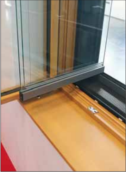
Der Wintergarten- und Fassadenhersteller Solarlux aus Melle bei Osnabrück stellte neu das Kastenfenster „Soundline M“ vor, eine Lösung für erhöhten Schallschutz in städtischen Wohnsituationen.
