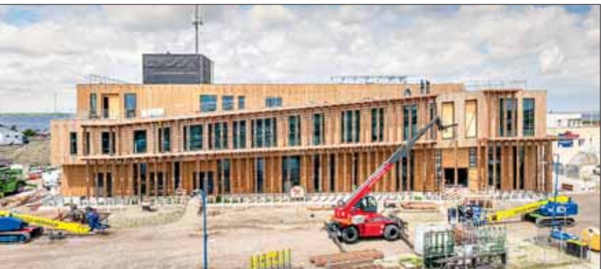
Neues Seehundzentrum im holländischen Lauwersoog: Die Fassade des Neubaus besteht aus recycelten Tropenhölzern, die zuvor als Reibepfähle innerhalb eines Kieler Hafens dienten und nun einen zweiten Lebenszyklus durchlaufen.
