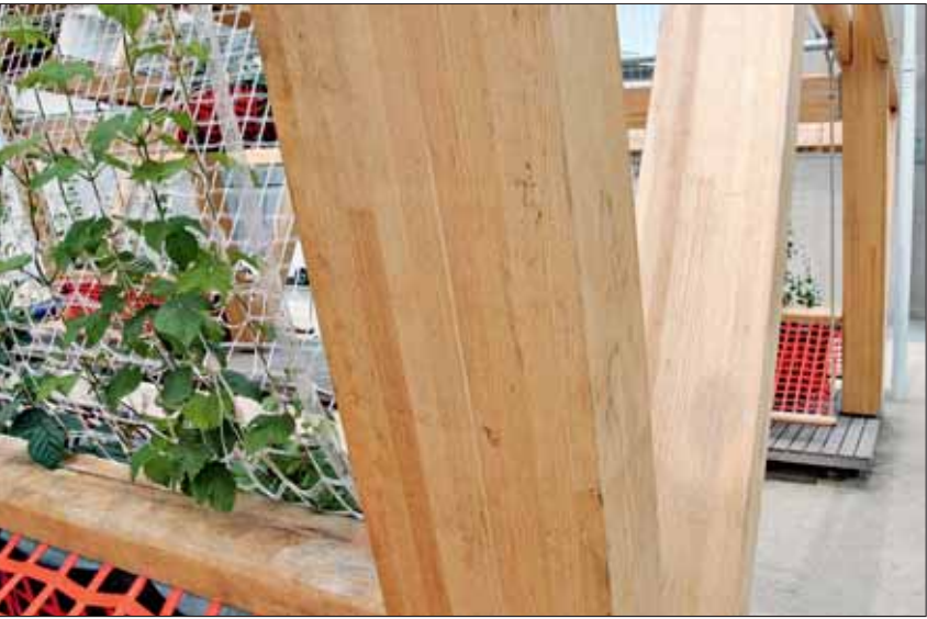
Das Objekt „Vert“ zeigt, dass sich Amerikanische Roteiche zur Verleimung sehr gut eignet und damit beste Voraussetzungen mitbringt, um künftig als Brettschichtholz in tragenden Holzkonstruktionen eingesetzt zu werden.
