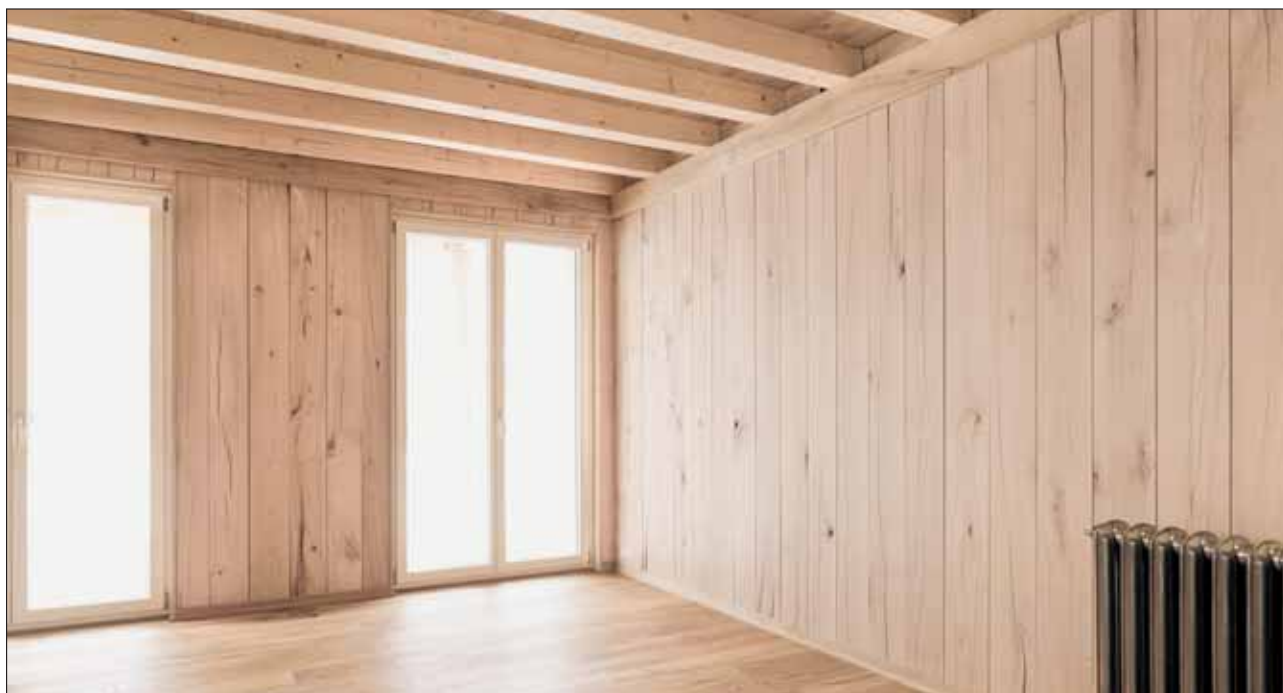
Die Firma Natürlicher Meister Holzart aus Thayngen (Schweiz) stellte einige tragende Wandstrukturen aus Buchenholz vor, die mittels spezieller, radialer Einschnittstechnik erzeugt wurden. Foto: Natürlicher Meister Holzart
