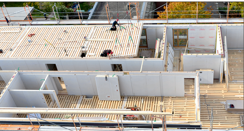
Beim Bau des Wohn- und Gewerbegebäudes „Buggi 52“ in Freiburg ...
