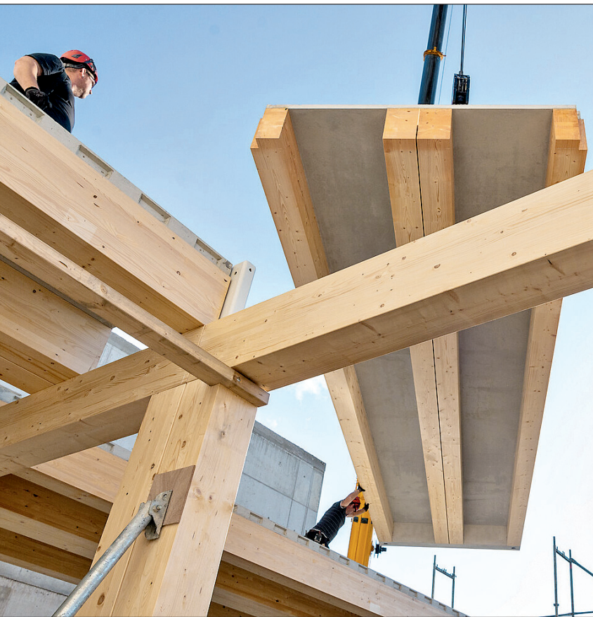
Ein Großversuch zur Kreislauffähigkeit ganzer Bauteile wurde kürzlich bei der Brüninghoff-Gruppe, Heiden, gefahren. Foto: Brüninghoff
