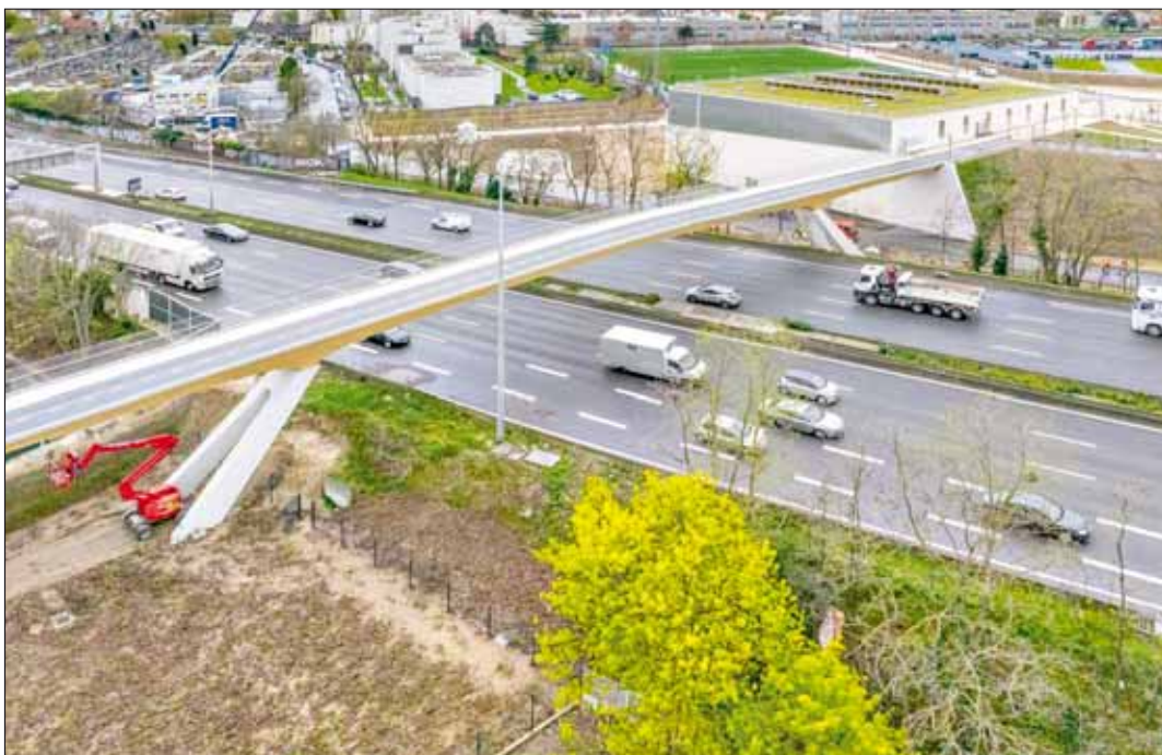
Paris: Die Forderung nach einer 100 m langen und über 50 m frei über die Autobahn spannenden Brücke machte die Wahl einer geeigneten Bauform durchaus anspruchsvoll.
