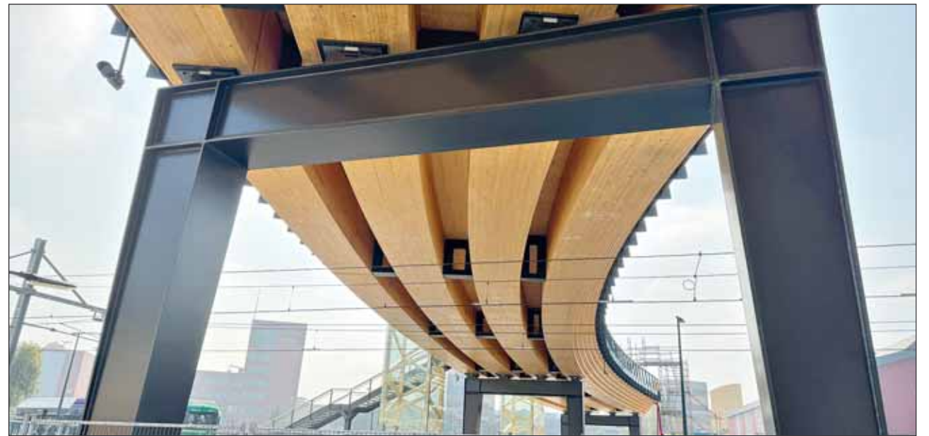
Über insgesamt zwölf Gleise führt die Fußgänger- und Radfahrer-Brücke in Zwolle und verbindet den Bahnhof mit dem südlichen, industriell geprägten Stadtgebiet. Fotos: Schmees und Lühn
