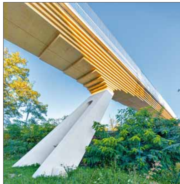
Der zweiteilige Brückenträger besteht aus Douglasienholz. Für Witterungsschutz sorgt ein wasserdichter Betonbelag mit Asphaltabdeckung, der durch Querlattungen aus Douglasienholz unterlüftet ist. Fotos: IB-Miebach
