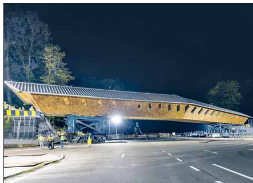
Der Transport der Fußgänger- und Radfahrerbrücke von der Montagestätte zu ihrem endgültigen Standort erfolgte in einem Stück, wodurch der Brüsseler Ring nur kurzzeitig gesperrt werden musste.
