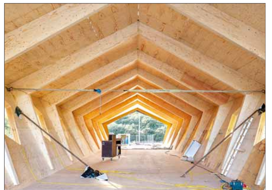
Die gesamte tragende Konstruktion der Brüsseler Brücke besteht aus Furnierschichtholz (LVL) des Herstellers Metsä und wurde in Dicken von bis zu 220 mm verbaut. Fotos: Corentin Haubruge
