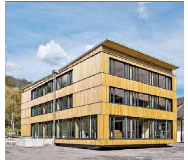
Die Firma Adams Holzbau-Fertigbau, Niederzissen, hat ihren neuen Stammsitz gleich selbst geschaffen – modern und nachhaltig. Foto: Dominik Ketz
