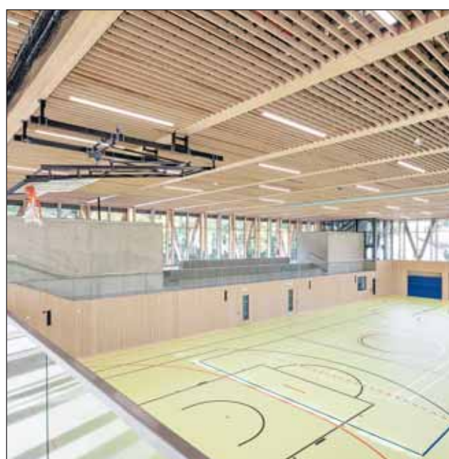
Auf Grund der Fachwerkträger-Konstruktion aus Buchenholz schwebt die neue Kultur- und Sporthalle in Alfter auskragend auf V-förmigen Holzstützen und wirkt somit leicht und transparent. Fotos: Margot Gottschling
