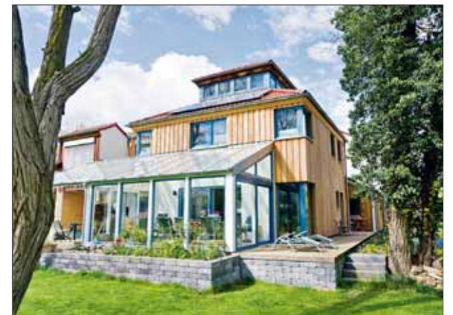
... konnte aber durch Trockeneis-Reinigung der Hölzer vor dem Abriss bewahrt werden. Fotos: Susanne Rauff
