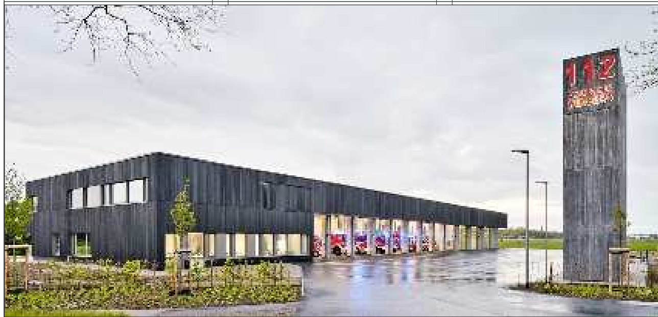
Die neue Feuerwache in Wegberg ist einer der Preisträger des diesjährigen Holzbaupreises NRW und wird fassadenseitig durch ein traditionelles japanisches Verfahren, die Karbonisierung, geschützt. Foto: Constantin Meyer
