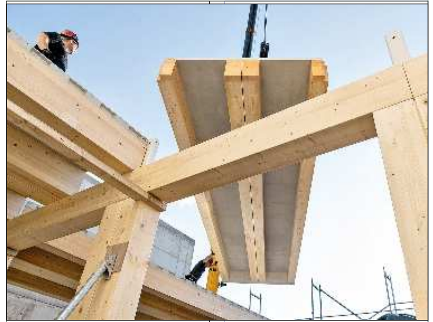
Ein Großversuch zur Kreislauffähigkeit des Recyclings und der Wiederverwendung von Holzbeton-Verbunddecken im Sinne des Recyclings und der Wiederverwendung ganzer Bauteile wurde kürzlich bei der Brüninghoff Group, Heiden, gefahren. Foto: Brüninghoff Group
