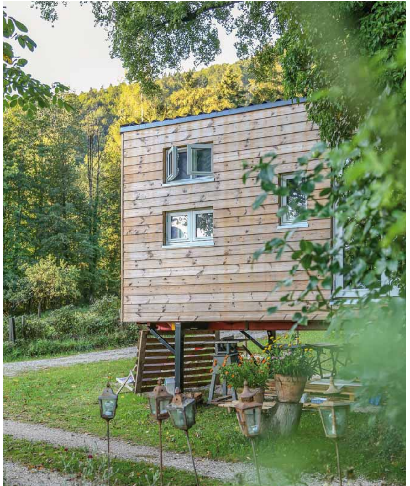
Rückzugsort: Das Tiny House fügt sich perfekt in die Landschaft des Chiemgaus ein. Die Konstruktion auf einer Lkw-Wechselbrücke gewährleistet einen problemlosen Umzug des Hauses. Fotos: Elka-Holzwerke
