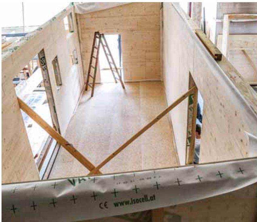
Im Fußbodenaufbau kamen diffusionsoffene Platten von Elka zum Einsatz. Die Innenwände wurden mit Elka-Naturholzplatten beplankt.
