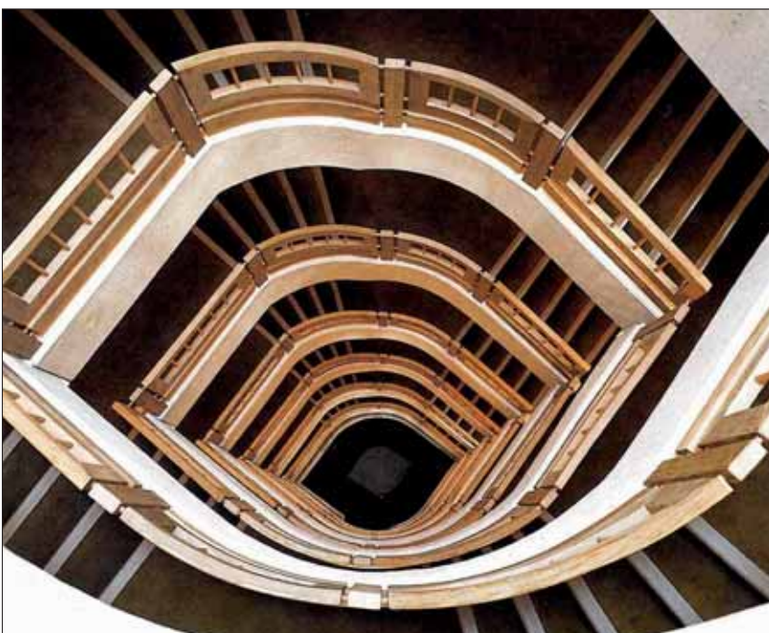
Die zentrale Treppenanlage des „Turmes“ weist die Form eines stilisierten Baumblattes auf und ist seit fast 50 Jahren Blickfang für Besucher sowie Mitarbeiter des Verlages.
