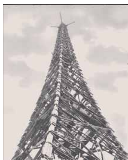
Eiffelturm? Nein, ein Funkmast aus Holz
