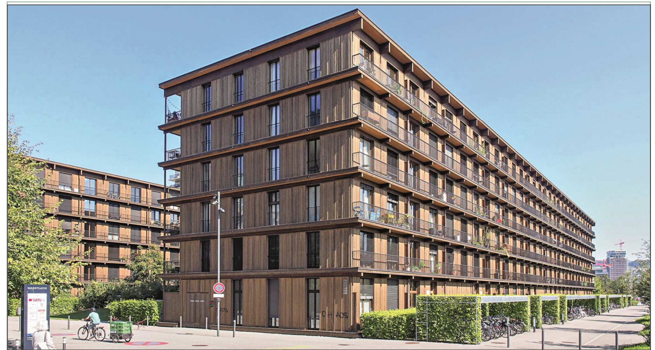
Ein neues Quartier im Züricher Stadtteil Albisrieden auf dem Areal des ehemaligen Zollfreilagers besteht aus insgesamt zwölf Gebäuden. Drei davon wurden in Holzbauweise errichtet und umfassen 187 Wohneinheiten. Foto: S. Klein
