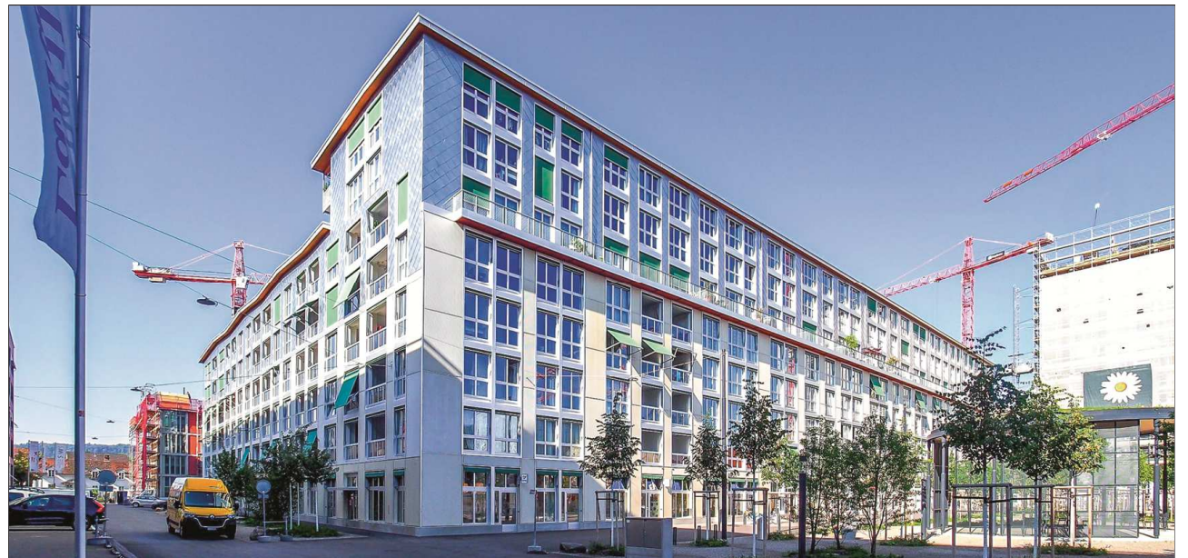
Das Projekt „Krokodil“ im Zentrum von Winterthur wurde nach einem alten Loktyp des ehemaligen Eisenbahngeländes benannt und umfasst als Blockrandbebauung 254 Wohneinheiten in Holz-Skelettbauweise. Foto: SDG21.eu
