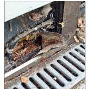
dauerhaft außerhalb der Reichweite von Bodenfeuchtigkeit, Spritzwasser und Kapillarwasser hält. Sollte nun der Bauherr mit einem Hauseingang liebäugeln, der ebenerdig und damit auf Höhe der wasserführenden Schicht liegt, seien ihm seitens des Planers oder Zimmerers die damit verbundenen (Feuchte-)Risiken klar aufzuzeigen.
