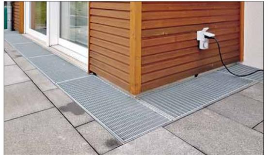
Dieser Sockel, der einen ebenerdigen und barrierefreien Zugang zum Gebäude ermöglicht, wird dauerhaft und sachgerecht von einer Drainageschicht (Schotter- oder Kiesbett) und einem darüber verlaufenden Gitterrost vor Bodenfeuchte und Niederschlagswasser geschützt. Fotos: Joh.-Ulrich Blecke (4)
