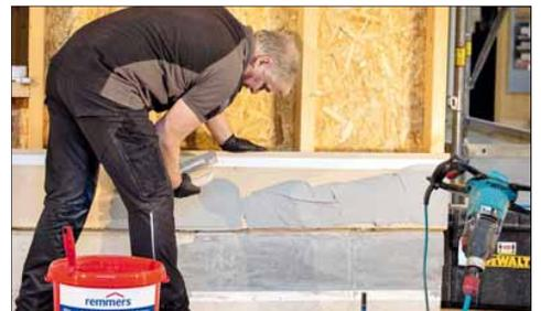
Remmers-Mitarbeiter Heinz-Jürgen Rohmann demonstrierte während des Seminars typische Abdichtungsarbeiten an Sockel, Türen und (bodentiefen) Fenstern, wobei eine sogenannte flexible polymere Dickbeschichtung (FPD) zur Anwendung kam. Foto: Zentrum Holz
