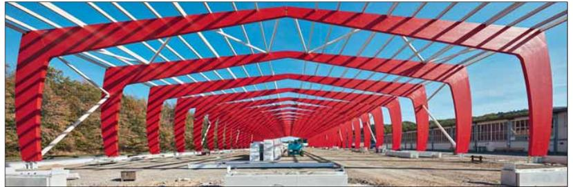
Fast 50 m überspannen die Dreieckenrahmen aus Brettschichtholz, welche die tragende Konstruktion der neuen Fertigungshalle in Westerkappeln bilden. Die BSH-Träger wurden bei Derix selbst produziert.
