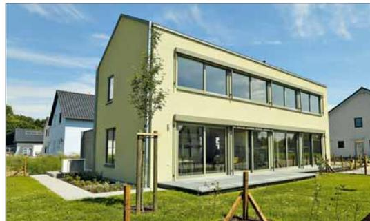
Das Gebäude der Faktor X-Agentur in Inden wurde 2017 mit Wandelementen aus Brettspertholz sowie Holzbalkendecken errichtet. Als Dämmung kamen Holzweichfaser-Platten zum Einsatz, zudem wurde auf einen Keller verzichtet. Das zweistöckige Bürogebäude erreicht über den gesamten Lebenszyklus einen Faktor X von 3,6. Fotos: Faktor X-Agentur
