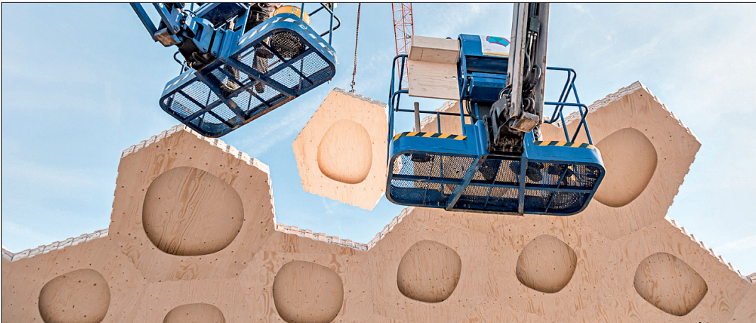
376 großformatige Holzkassetten mit polygonalen Formen bilden den Holzpavillon. Das geringe Gewicht der Schalensegmente sowie eine kraft- und formschlüssige Verbindung untereinander ermöglichen eine Montage im freien Vorbau. Fotos (2): ICD-ITKE
