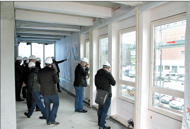
Die Außenwand mit ihren tragenden Holzstützen wird von innen in Gänze sichtbar bleiben
