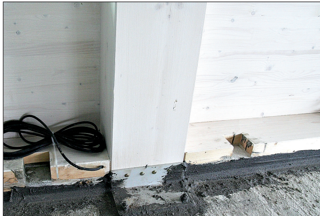
Anschluss der BSH-Stützen an Betondecke mittels eines Winkel eisens
