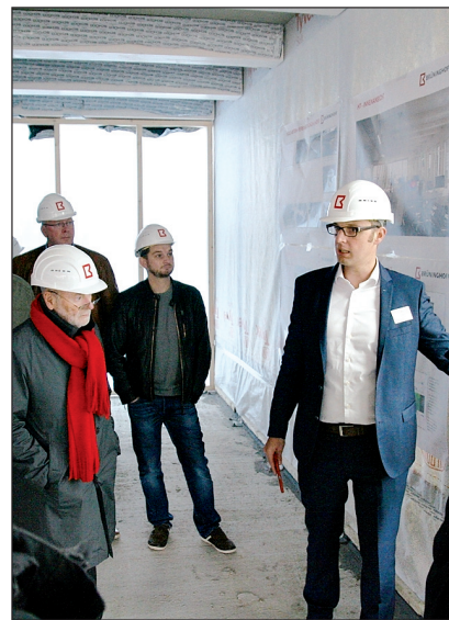
Brüninghoff-Geschäftsführer Frank Steffens führte interessierte Besucher durch den Rohbau im Münsteraner Hafen
