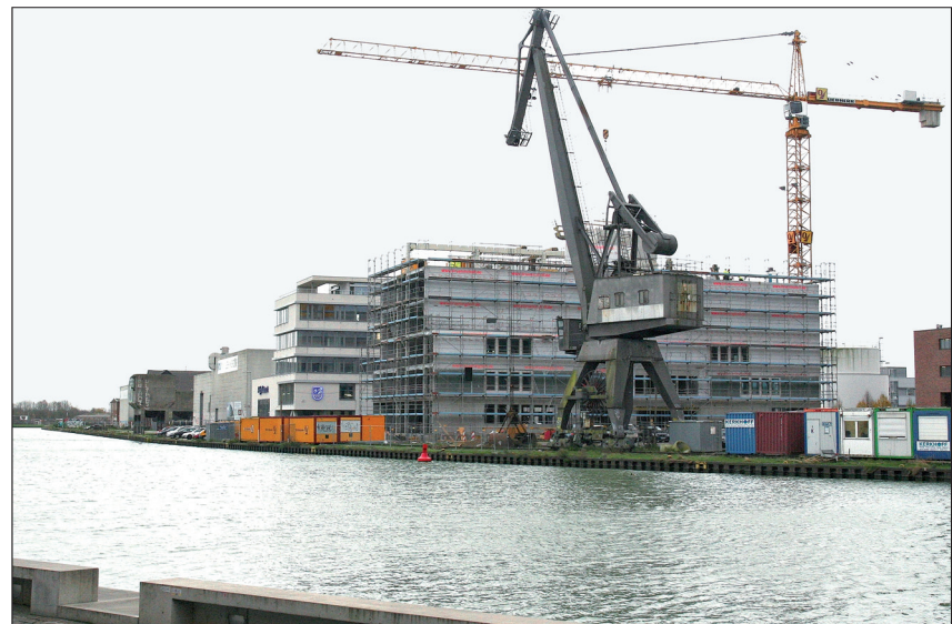
Die vorgefertigten Holzwannelemente werden sorgfältig eingepackt und somit gegen Regen und Schmutz geschützt. Fünf der geplanten sieben Stockwerke waren Mitte November fertig gestellt.
