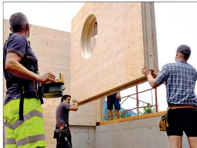
Die Verbindung der einzelnen Elemente erfolgt mittels Nut und Feder sowie mit fünf Schrauben pro Stoß und Geschoss. Fotos: Thoma Holz (5)
