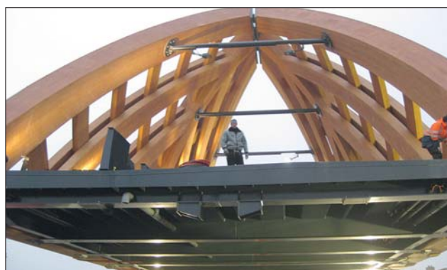
Zusammen mit dem Stahldeck der Fahrbahn ergeben sie das Tragwerk der Brücke.
