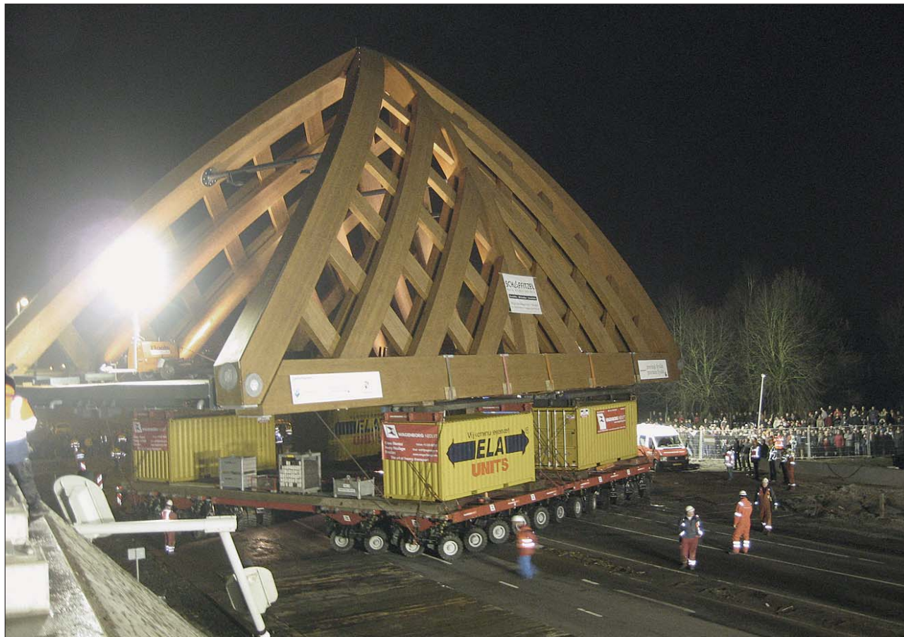
Dem Schauspiel der nächtlichen Montage der Brücke wohnten zeitweilig hunderte Schaulustiger bei.
