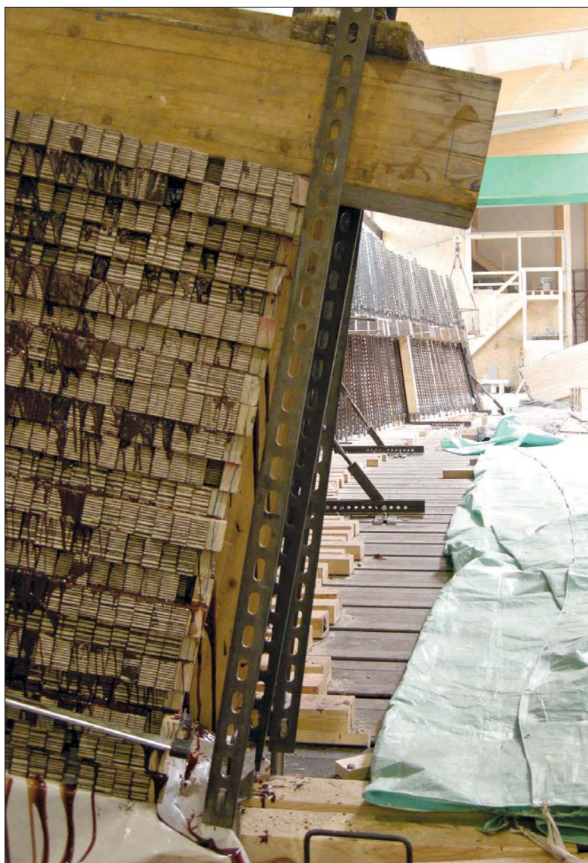
Zweiachsig gekrümmter Koloss aus Brettschichtholz, im Leimbett blockverklebt.
