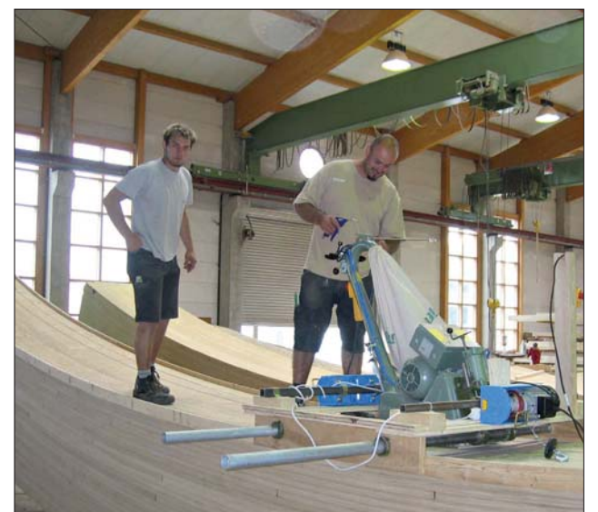
Oberflächenfinish der Brettschichtholzträger. Im Prinzip wie beim Abschleifen von Holzböden.
