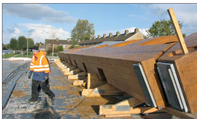
Vor-Ort-Montage der beiden Holzfachwerk-Halbschalen aus mächtigen Einzelbauteilen.
