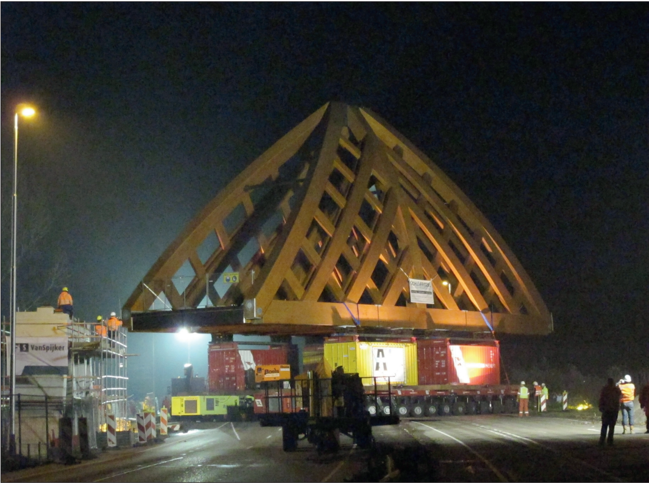
Spektakuläre Montage der Schwerlastbrücke auf der niederländischen Autobahn A7 bei Sneek
