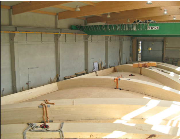
Vormontage einer der beiden Fachwerkschalen, die zusammen mit der Holzfahrbahn das Tragwerk der Brücke ergeben.
