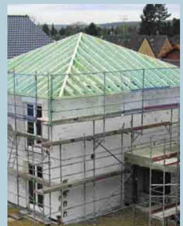
Perfekt gesichertes Gebäude. Rutscht ein Zimmerer vom Dach ab, hält ihn spätestens das Fanggerüst auf
