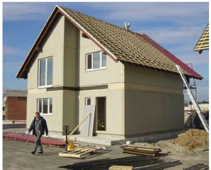
Eine Putzfassade sowie großflächige Dachelemente mit Bitumdeckung schützen vor der Witterung.
