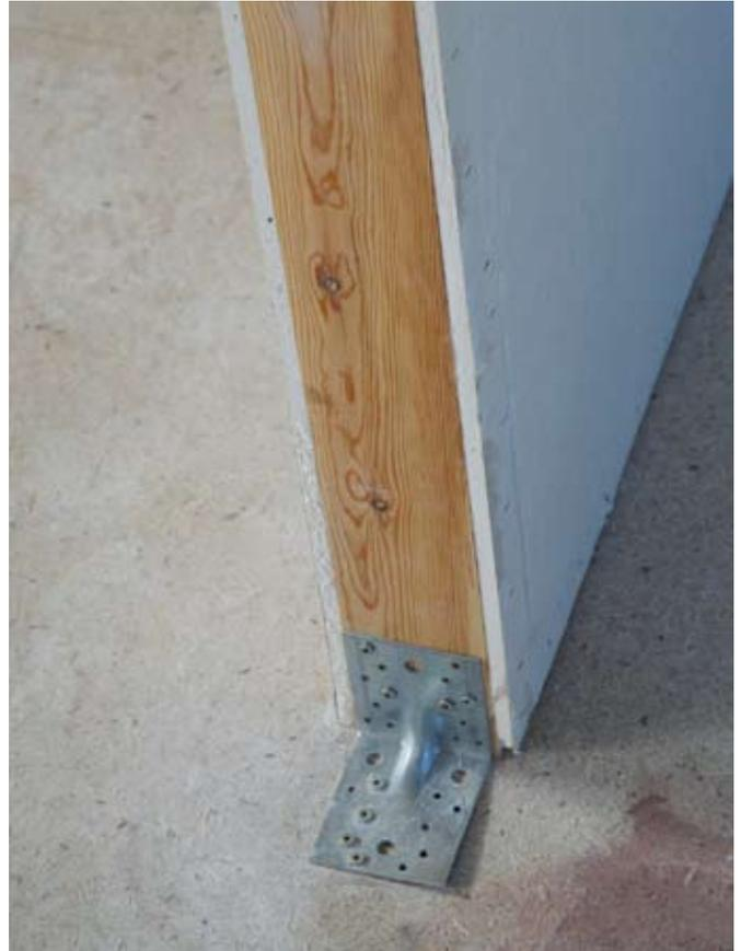
Die Innenwände der standardisierten Häuser sind beidseitig mit Gipskartonplatten beplankt.
