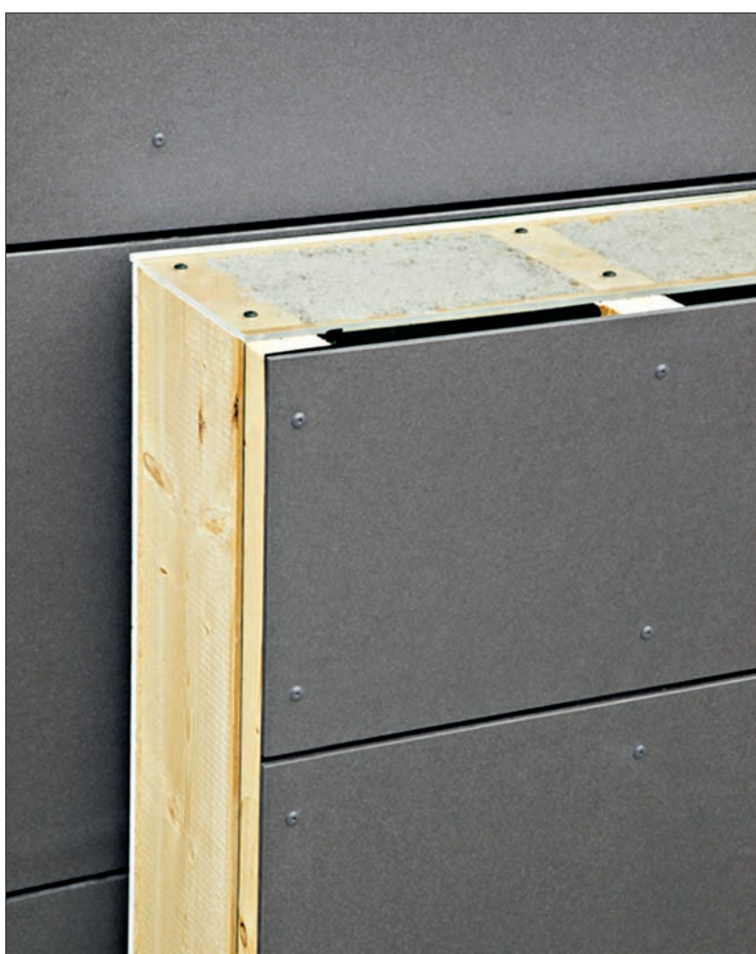
Wandelemente in Holzrahmenbauweise mit Cellulose-Dämmung flossen ebenfalls positiv in das Nachhaltigkeitskonzept der Architekten ein.
