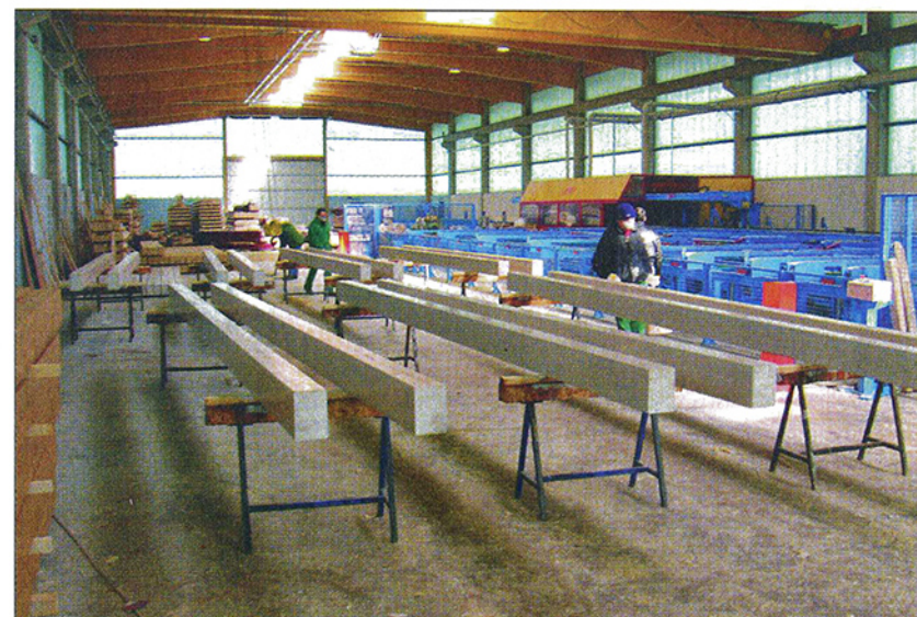
Die Träger aus Brettschichtholz wurden im Werk in Südtaliesien fix und fertig abgebunden und mussten vor Ort nur noch montiert werden.
