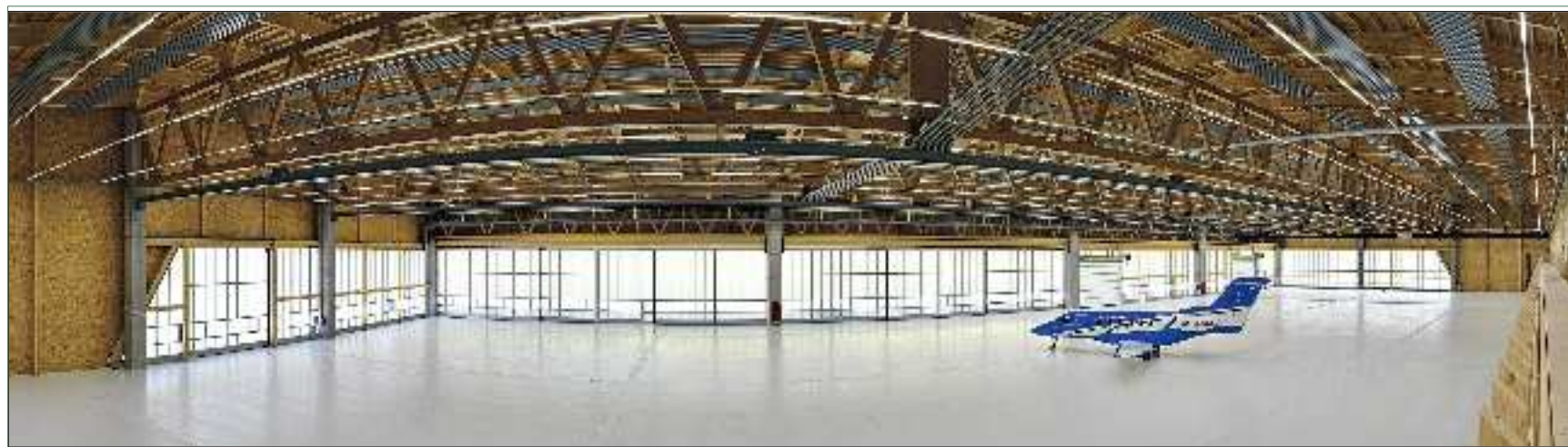
Fachwerkträger aus Buchen-Furnierschichtholz überspannen diese neue Flugzeughalle im schweizerischen Stans auf einer Länge von über 100 m. Foto: Neue Holzbau
