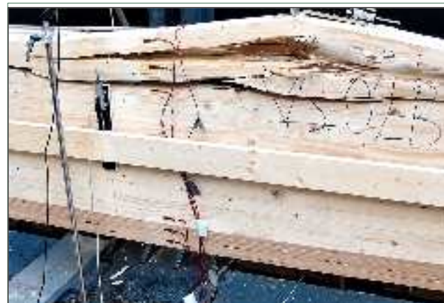
Wird Brettsperrholz aus Fichte auf der Zugseite mit Furnierschichtholz aus Buche oder Birke verstärkt, so muss mit einem Versagen dieses Verbundträgers in der Druckzone (also auf der Oberseite) gerechnet werden. Foto: MPA Stuttgart
