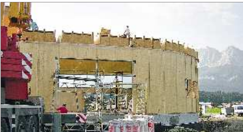
Dieser Lebensmittelmarkt der Firma M-Preis wurde nahe Reutte (A) auf 1039 m über dem Meeresspiegel gebaut; sein Rohbau setzt sich zusammen aus Brettsperrholz-Wänden sowie wärmegeprägten Sandwichelementen (bestehend aus Brettsperrholz und OSB). Foto: Brunnstener
