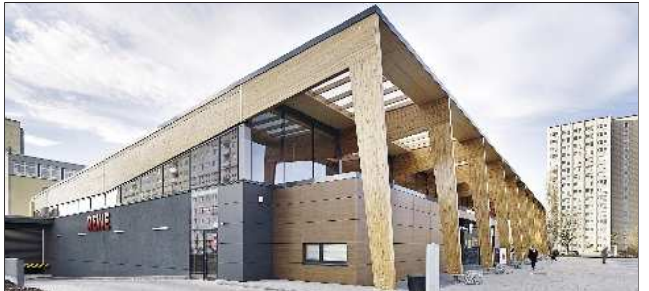
Dieser Rewe-Supermarkt in Leipzig wurde im Rahmen der Mehrfachzertifizierung der DGNB ausgezeichnet. Dabei ist der Baustoff Holz – in Tragwerk, Fassade und Decke – als Symbol für nachhaltiges Bauen nicht zu übersehen. Foto: Rewe
