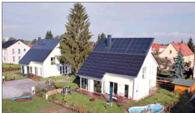
In diesen Plusenergiehäusern dürfen sich die Bewohner sogar eine gewisse Energieverschwendung erlauben. Foto: Leukefeld
