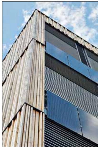
Die Douglasien-Fassadenelemente der Natur- und Forstverwaltung in Diekirch (Luxemburg) wurden im Werk vorgefertigt. Fotos (2): Morph 4 Architecture
