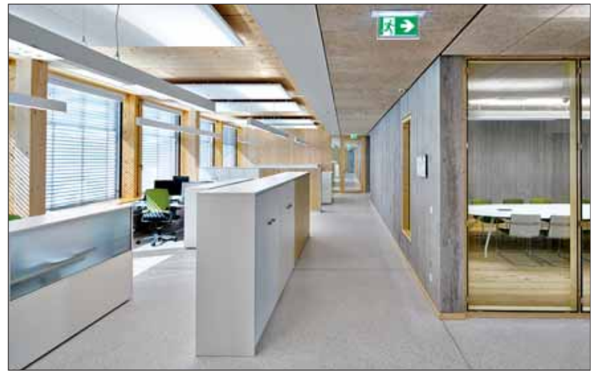
Die neue Natur- und Forstverwaltung im luxemburgischen Diekirch wurde als Plusenergiegebäude geplant und in Holzskelettbauweise realisiert.
