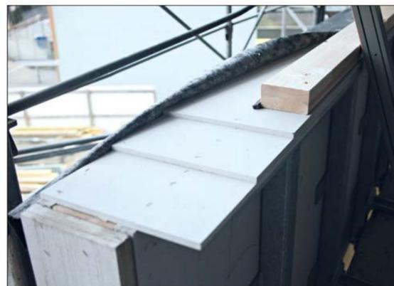
Bestimmte Bereiche wie die Brüstungen wurden erst nach Montage mit Gipsfaserplatten verkleidet
