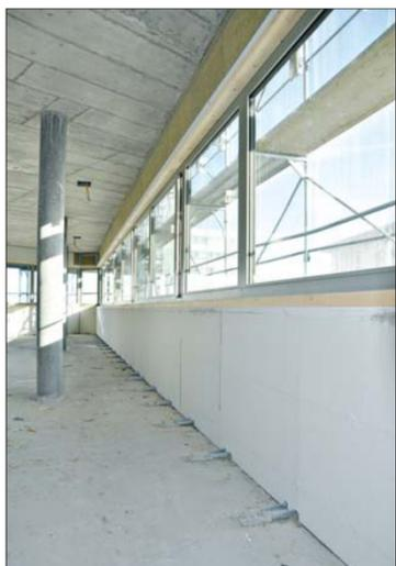
Der Rohbau nach Einbau der Holz-Gips-Fassadenelemente
