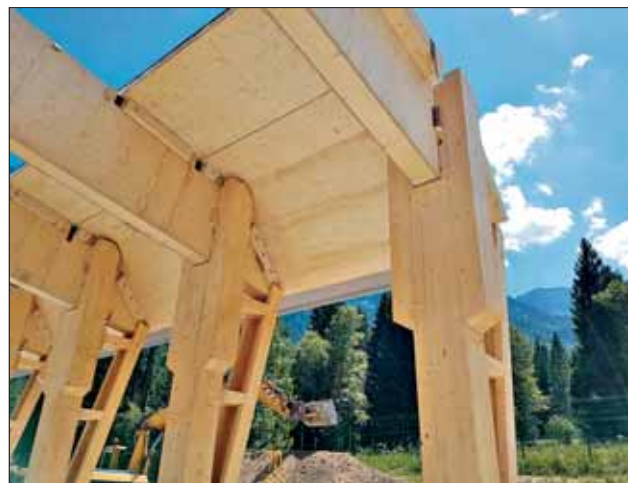
An die Stützen geklebte Holzgabeln sichern die Satteldachträger in ihrer Position.
