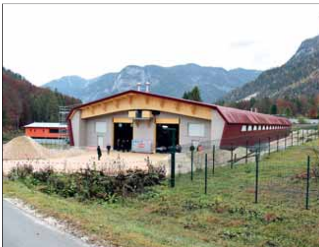
Ein Bauwerk komplett frei von Stahlteilen, welches die derzeitige Leistungsbreite der Verklebungstechniken im Holzbau verdeutlicht.
