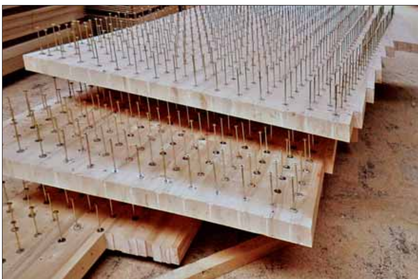
Mittels Schraubenpressklebung werden Furnierschicht-holz-Platten auf den Satteldachträgern befestigt.
