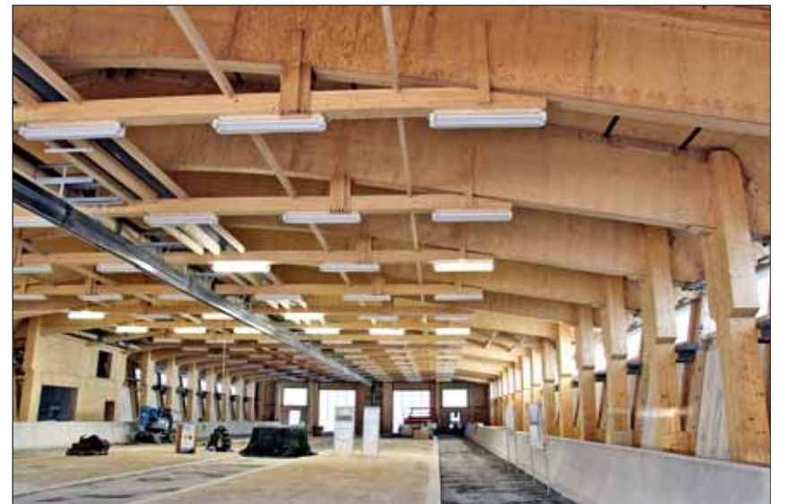
In der 75 m langen und 25 m breiten Halle wird die Bundeswehr künftig elektronische Geräte testen. Fotos: Rubner Holzbau
