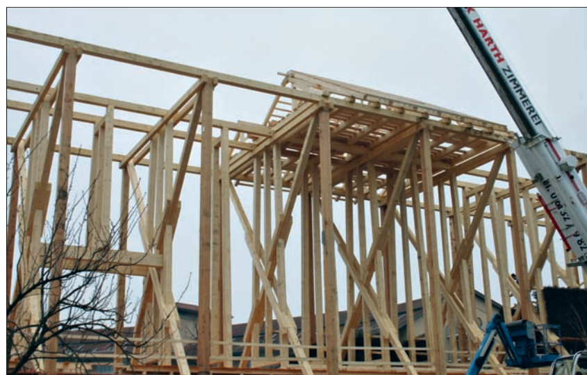
Alle Gebinde werden auf der Baustelle zusammengefügt und mit dem Autokran aufgerichtet.
