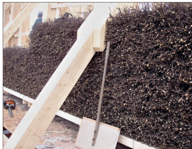
Einbau von Schwarzdorn-Reisig in das Gradierwerk, über die später die Sole verrieselt wird.
