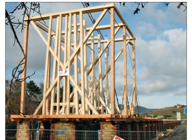
Die ersten drei von 73 Hauptgebänden aus Fichte und Lärche sind aufgestellt.
