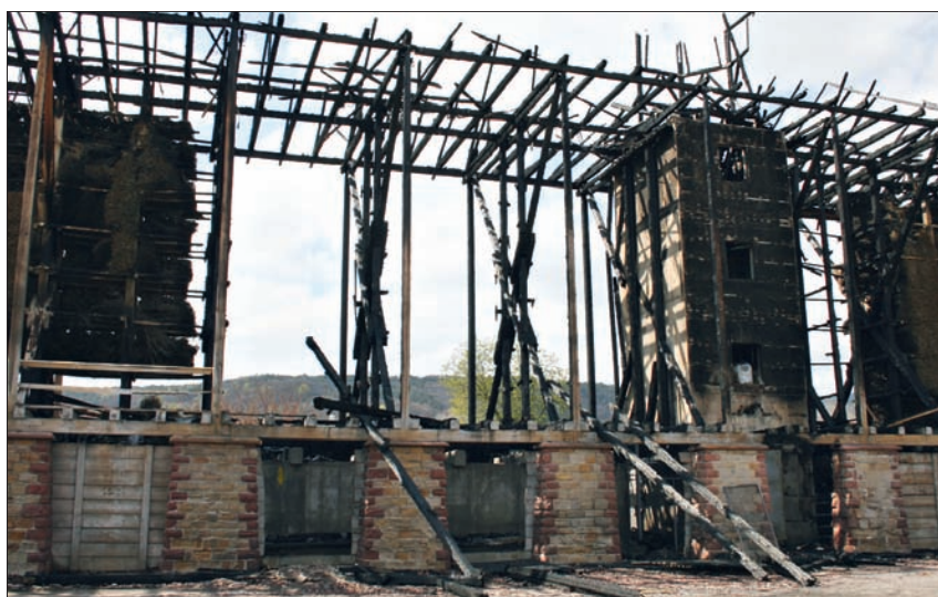
Die stärkeren Hölzer der Hauptkonstruktion und die Steinsockel widerstanden dem Feuer, das Dach jedoch brannte vollständig ab.
