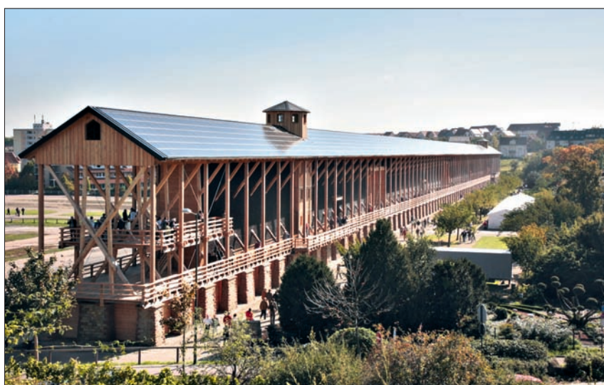
Gradierbau mit Fotovoltaikelementen als Dacheindeckung und einer integrierten Sonnenterrasse Fotos: Stadt Bad Dürkheim (4), Zimmerei Harth (1)
