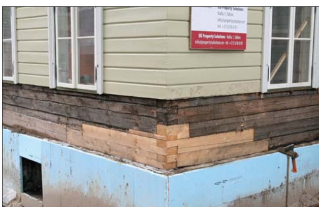
In Tallinns alten Holzbauten finden sich Eckverbindungen in Form schräger Überblattungen – wie im traditionellen Fachwerkbau in Mitteleuropa. Hier wird alte Substanz teilerneuert.
