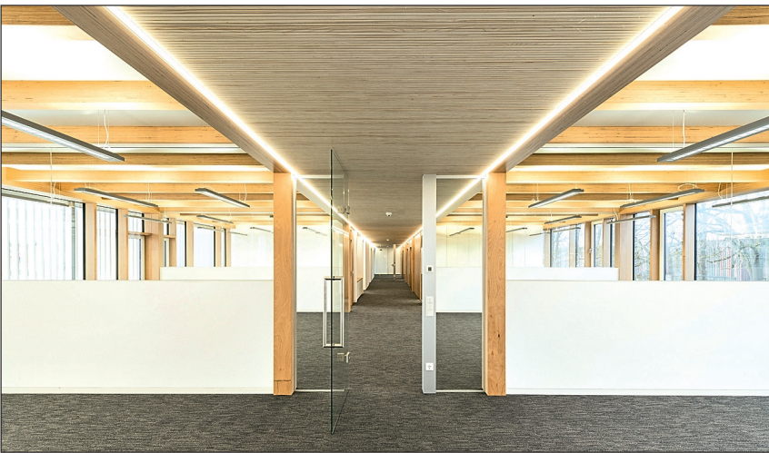
Unter dem Titel „Dreimal Buche“ beschrieb Frank Lattke seine Erfahrungen bei der Umsetzung eines dreigeschossigen Holz-Skelettbau in Augsburg, bei dem konsequent Furnierschichtholz aus Buche für Tragwerk, Fassade und Innenausbau eingesetzt wurde. Foto: Eckhart Matthäus
