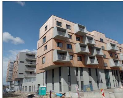
Dieser Gebäudekomplex im Wiener Stadtentwicklungsgebiet „Seestadt Aspern“ wurde in Holzbeton-Hybridbauweise errichtet und mit einer hinterlüfteten Lärchenholzfasassade versehen. Foto: LC Buildings GmbH
