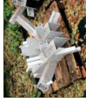
Komplexer Stahlknoten, wie er sich im frei bewitterten Übergangsbereich zwischen Rumpf und Schwanz findet
