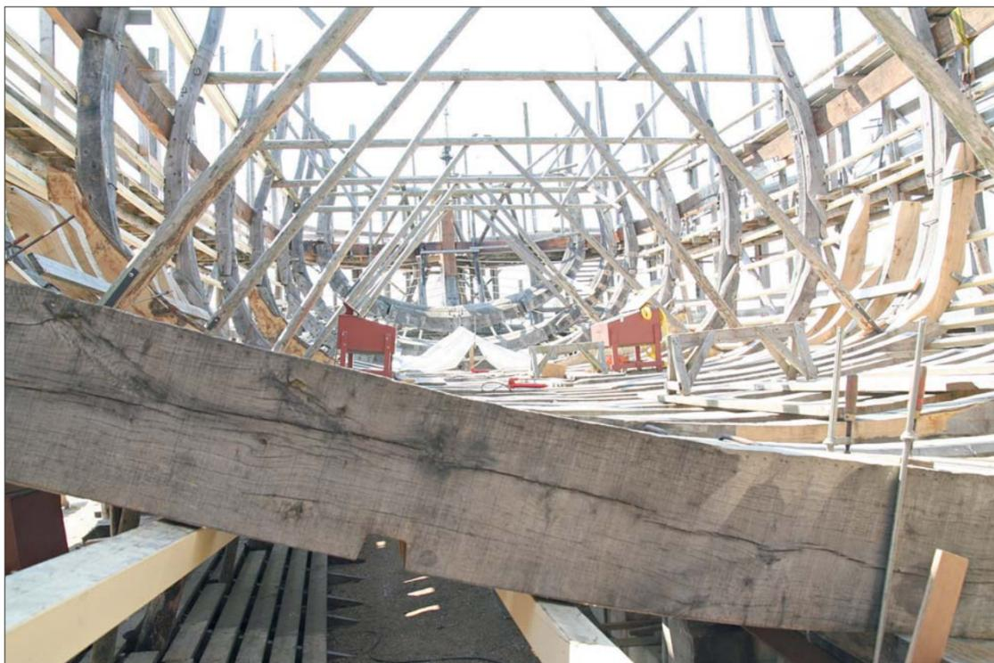
Froschperspektive im Rohbau der „Sieben Provinzen“, deren Spanten samt der mittig angebrachten Stützkonstruktion aus Rundhölzern wie ein Gerippe in den Himmel ragen.
