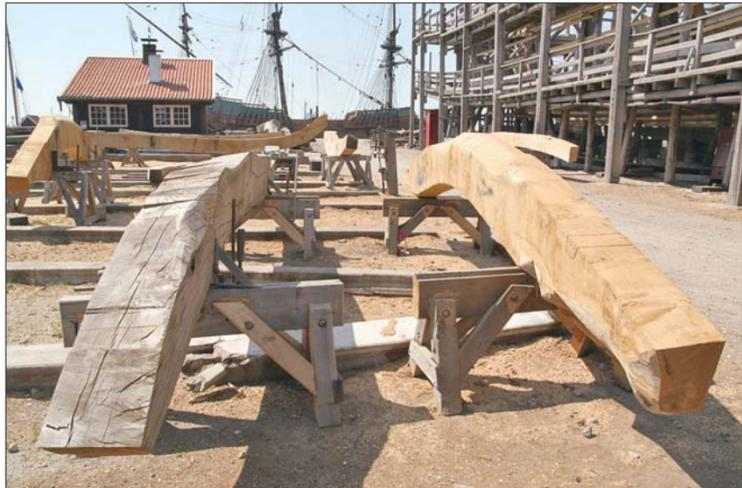
Massives Eichenholz bildet auch das Rückgrat des Schiffes; aus solchen mächtigen Krummhölzern werden vor allem die Spanten geformt.
